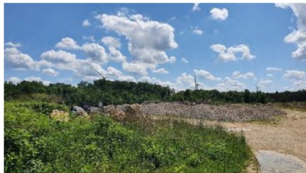
Vue en direction de l'est depuis la partie nord du site en remblais (vue sur l'alignement d'éolienne en construction au-delà des emprises de l'A10)
